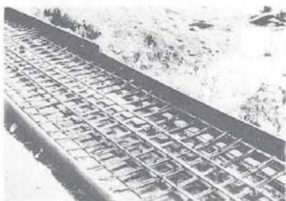
竹筋コンクリートの配筋状況
