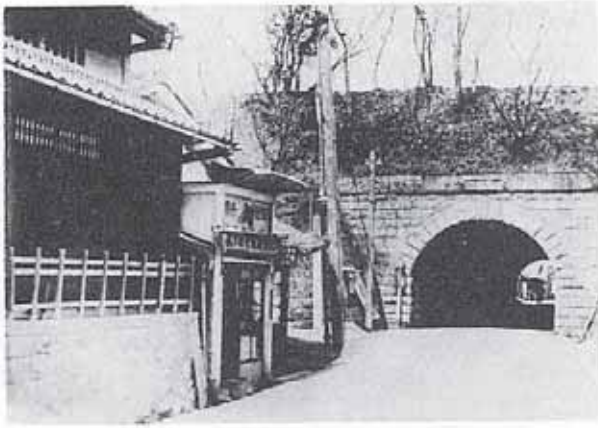
旧東海道（草津川トンネル）
