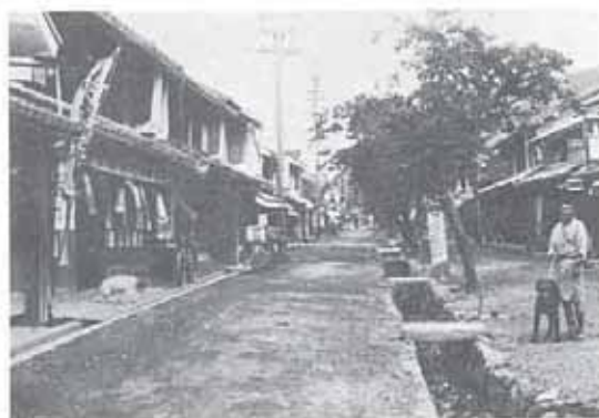
武生木之本線改修前 伊香郡木之本町木之本(S-5年項)
